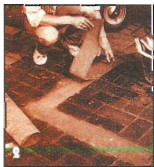
2 Полосы рубероида, уложенные на фундамент, защищают кладку от влаги.
