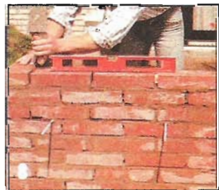
8 Еще два ряда — и боковые стенки будут готовы. Начинаящим умельцам желательно брать в руки уровень почаще.
