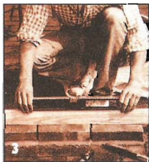
3 На рубероид кладут первый ряд кирпичей, выверяя его с помощью уровня и ровной рейки.
