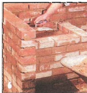
6 Внутреннюю полость гриля заполняют песком и битым камнем до уровня, не доходящего до верхних кромок внутренних стенок на высоту в полтора кирпича.
