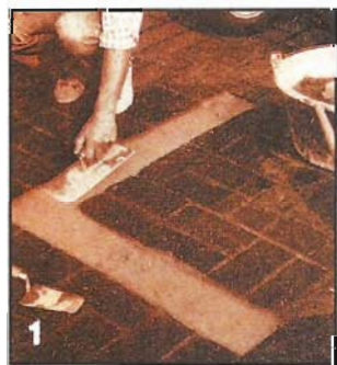
1 Место установки гриля — терраса, мощеная камнем. Фундамент заливают до уровня земли.
